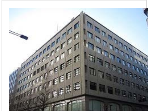
▲整理回収機構本社(東京千代田区新日石ビル内)
